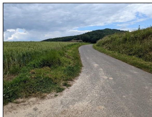
Abb. 11: Asphaltierte Straße im Norden des Plangebietes zwischen Intensivacker und Böschung (06/2024)
