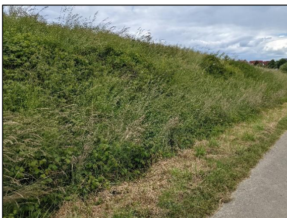
Abb. 12: Böschung im nördlichen Randbereich des Plangebietes (06/2024)
